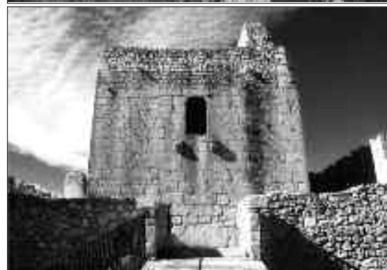
La torre centrale, parte più antica della rocca
